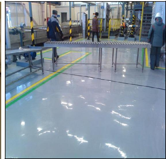
Производственное помещение, СУЭК, Бурятия
