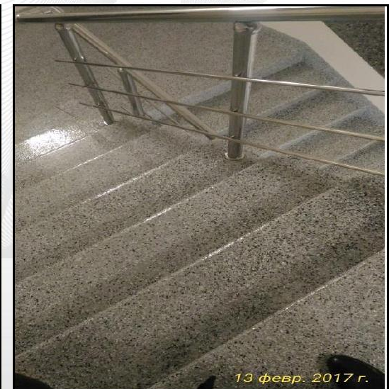
Реконструкция лестницы, г. Красноярск
