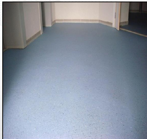
Лифтовые холлы жилого дома, г. Красноярск
