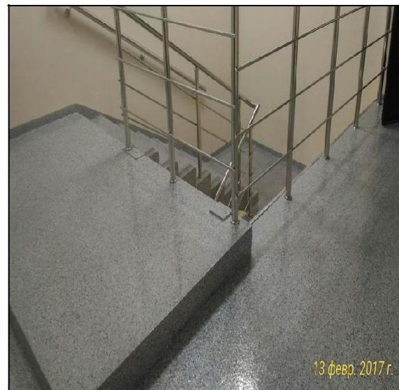
Здание ТФОМС, г. Красноярск
