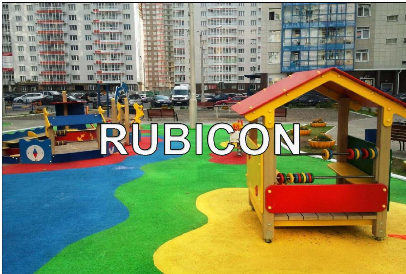
Детская игровая площадка, УК г. Красноярск. Площадка выполнена по технологии укладки на «УПЛОТНЕННЫЙ ГРУНТ» - песчано-гравийная подушка
