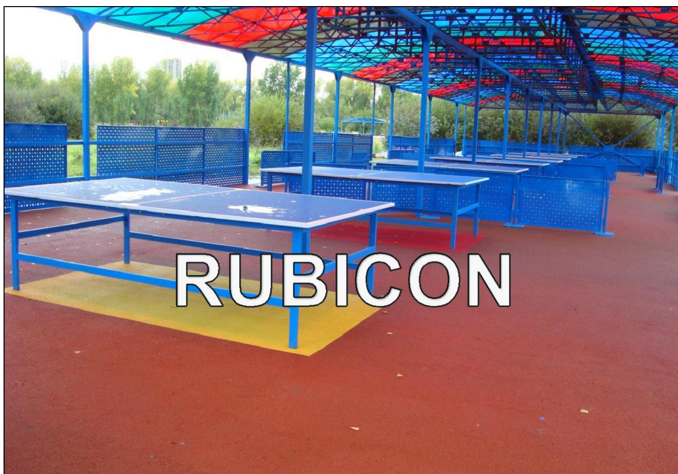
Теннисная площадка о.Татышева, г. Красноярск. Ремонт старого резинового покрытия и укладка нового слоя на бетонное основание, нанесение декоративных 5 зон на покрытие. Окраска ограждений, ремонт теннисных столов, ремонт кровли.
